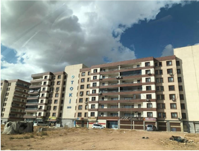
Figure 5. Immeubles construits par la TOKİ à Cizre (province de Şırnak)
