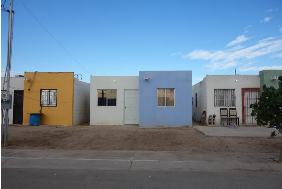
Figure 2. Logements sociaux individuels à Mexicali, ville mexicaine frontalière avec les États-Unis
