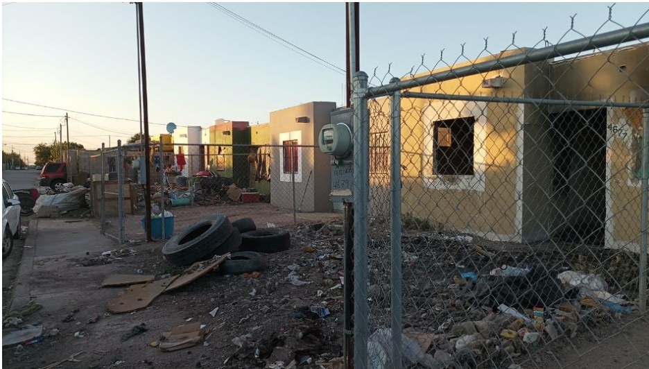
Figure 5. Abandon et vandalisation de logements sociaux à Mexicali
