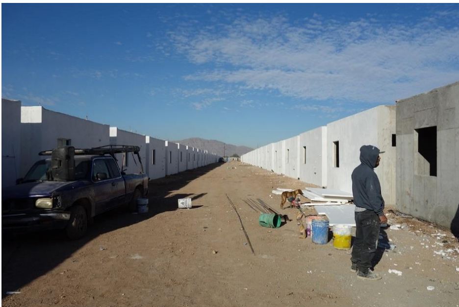
Figure 3. Nouvel ensemble d’habitat social en construction à Mexicali, Mexique
