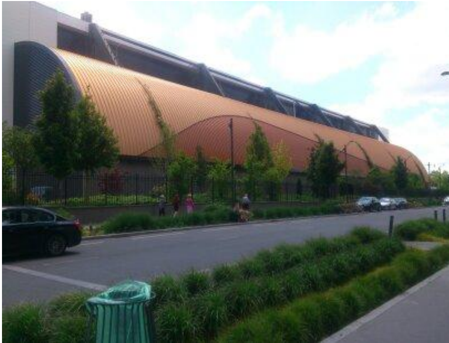
Figure 2. L'usine de la Compagnie parisienne de chauffage urbain sur le site des Docks, convertie en « éco-industrie » (Saint-Ouen, 2019)
