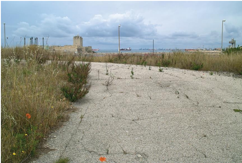
Figure 4. La friche s'installe sur le site déconstruit
