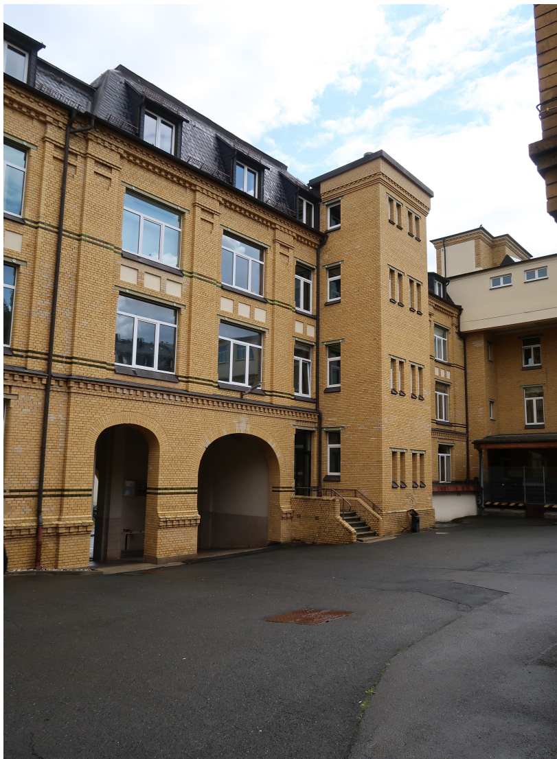
Figure 5. Dans la cour du bâtiment réhabilité des anciennes usines Narva
