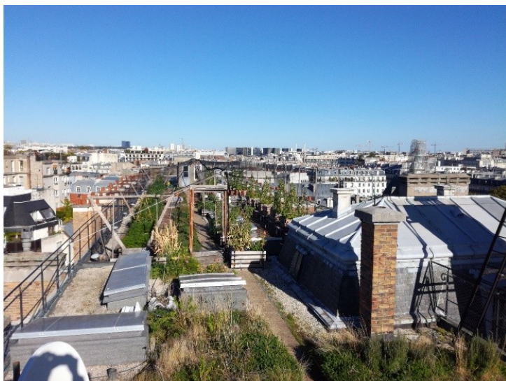
Figure 3. Des Technosols construits – Support de culture sur le toit potager expérimental d’AgroParisTech (projet de recherche T4P)
