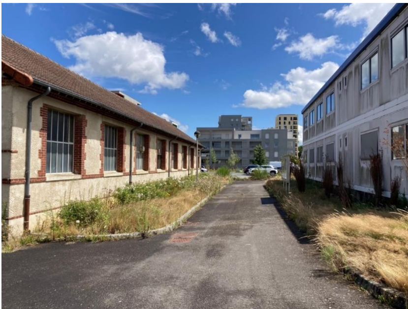
Figure 1 – Bâtiments du site de l'entreprise Euro-Shelter, état actuel
