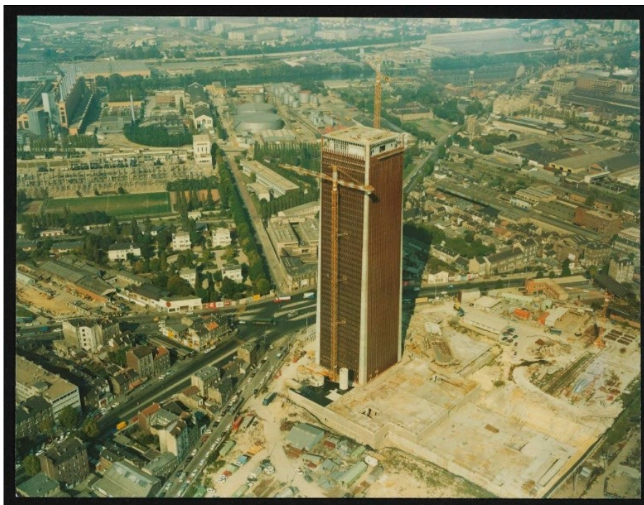
Figure 2. La tour Pleyel en chantier. Le carrefour Pleyel vu du sud-est (Saint-Denis, février 1973)
