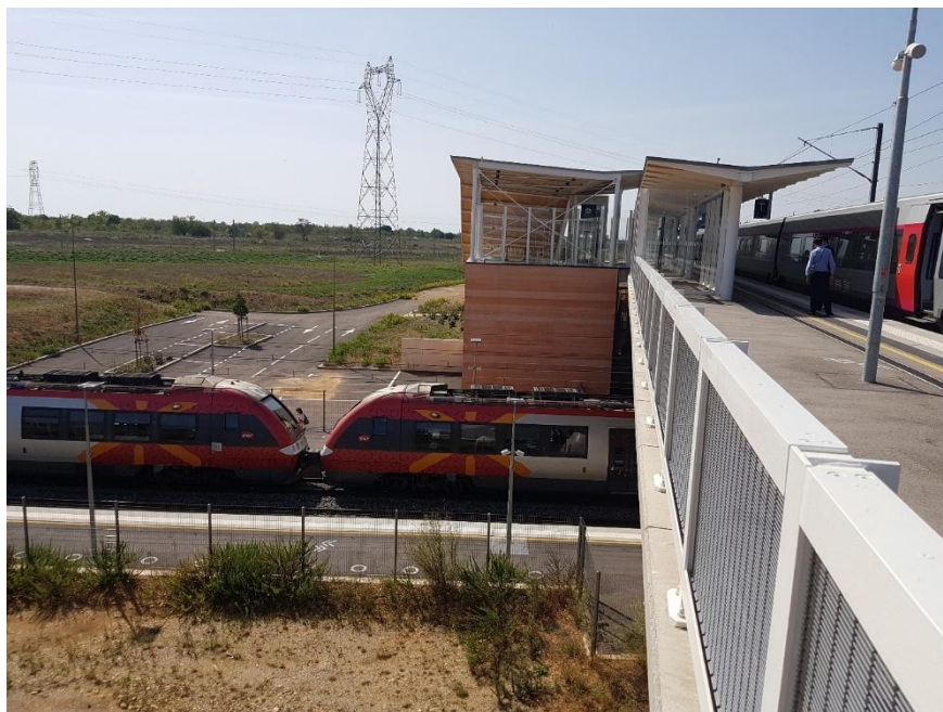
Figure 1. Correspondance TGV-TER en gare de Nîmes Pont-du-Gard
