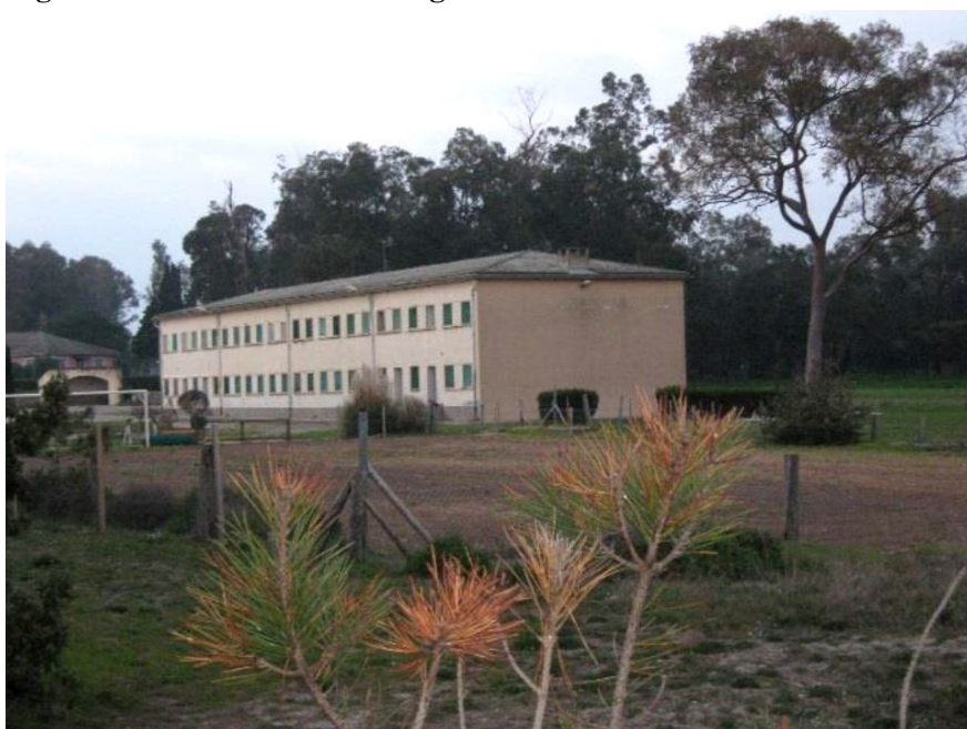
Figure 2. Un bâtiment d'hébergement du centre de détention de Casabianda en Corse
