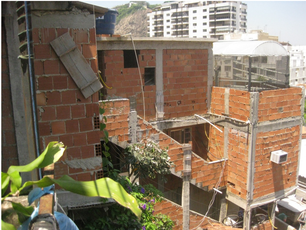
Figure 3. Nouvelles constructions pour location saisonnière à Chapéu Mangueira
