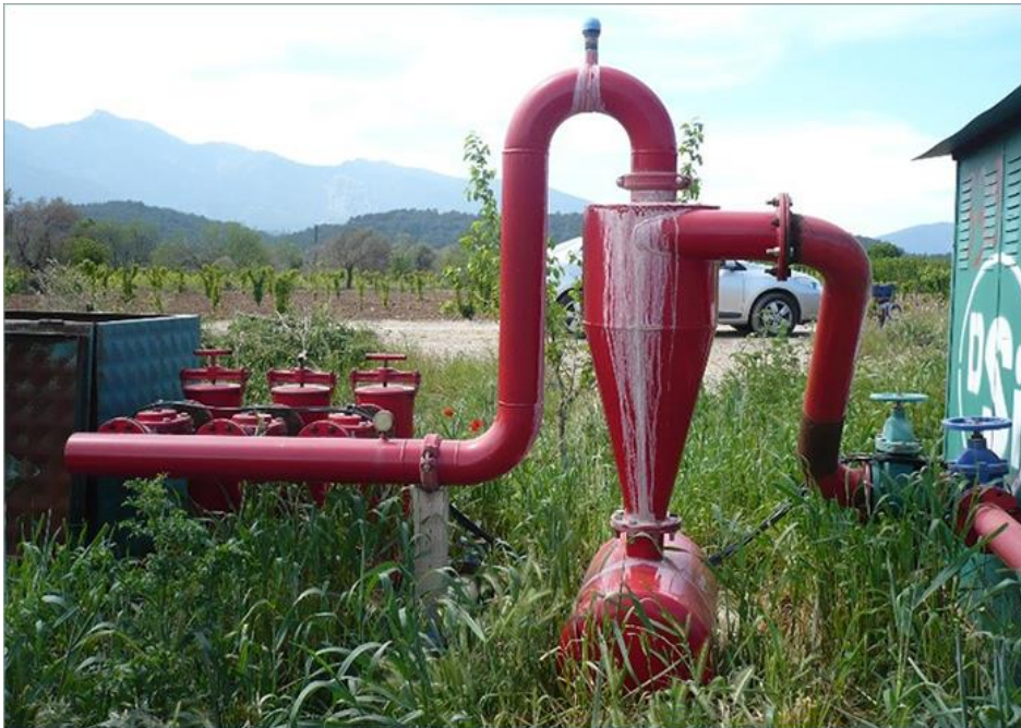
Figure 1. Forage collectif réalisé par le DSI à Armutlu, près d'Izmir
