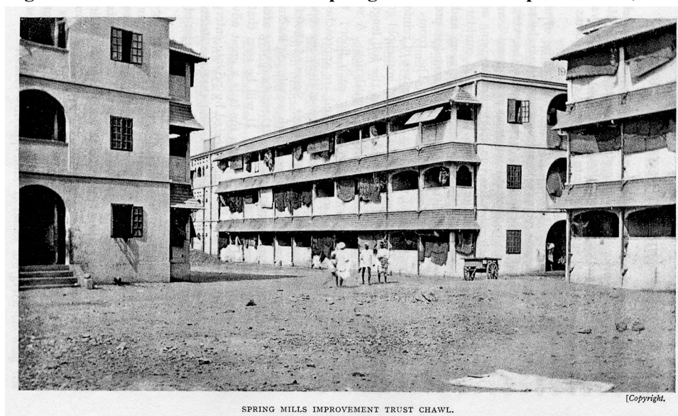
Figure 2. Chawls en béton armé de Spring Mills construits par le BCIT, années 1920
