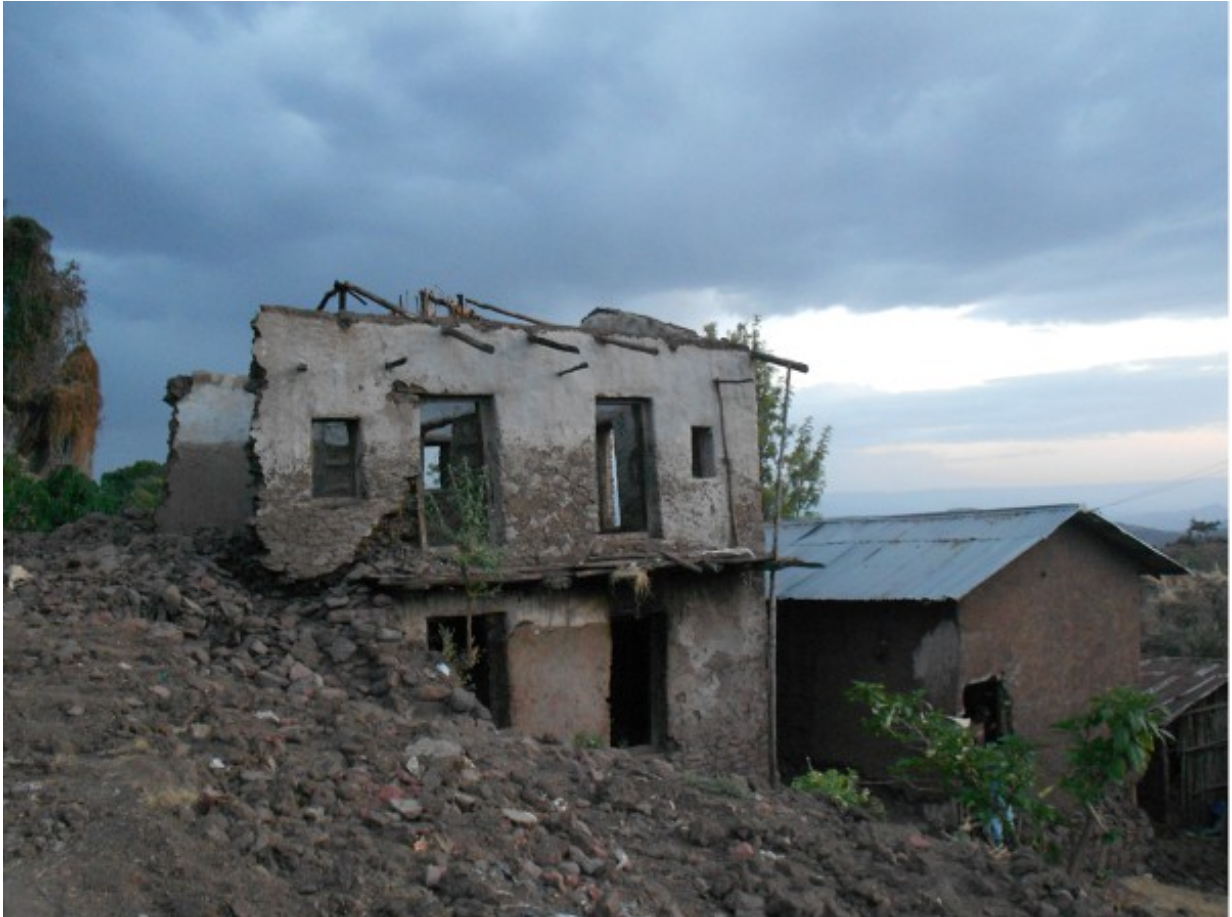
Figure 4. Destructions dans les alentours des églises de Lalibela
