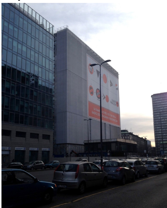
Figure 3. Démolition du siège régional de la caisse de retraite (INPS) rue Melchiorre Gioia (Milan) après son achat par le fonds souverain d'Abu Dhabi, pour le remplacer par le siège d'une banque lombarde
