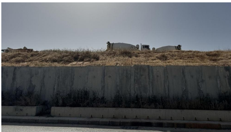
Figure 6. Flottes de camions et de bétonnières en route vers les remblais de Costa-Brava
